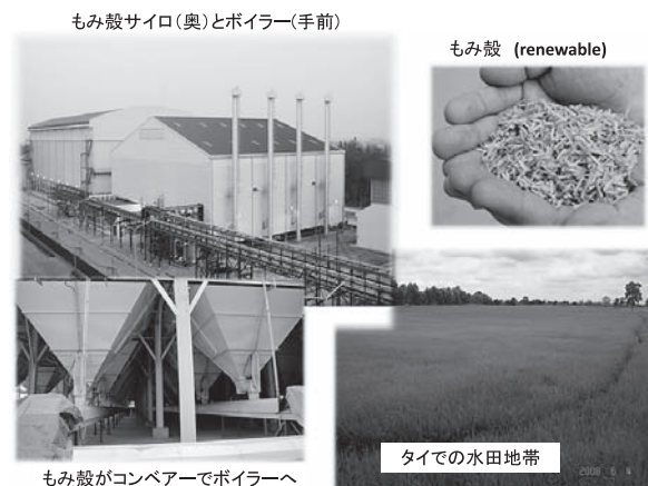
図2. 未利用バイオマスとしてのもみ殻を利用するボイラー。タイのアミノ酸工場に設置され、約1万トンのもみ殻を貯蔵できるサイロとボイラー。工場へのエネルギーを供給する。
