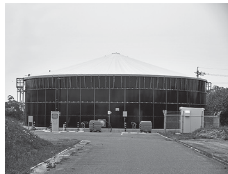
図2. 有機液肥貯留槽(築上町)
