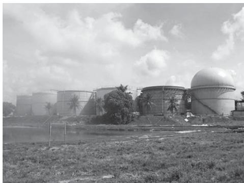
図2. FELDA社 Seriting Hilir工場に完成したパームオイル廃液の嫌気処理システム。2009年CDMとして国連に登録。
