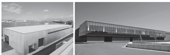
図1. 発酵設備を収容するPrototyping Studio (左) と紡糸設備を収容する本社研究棟 (右)
